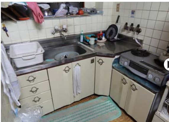
二階工事：水廻り入れ替え キッチン、洗面
